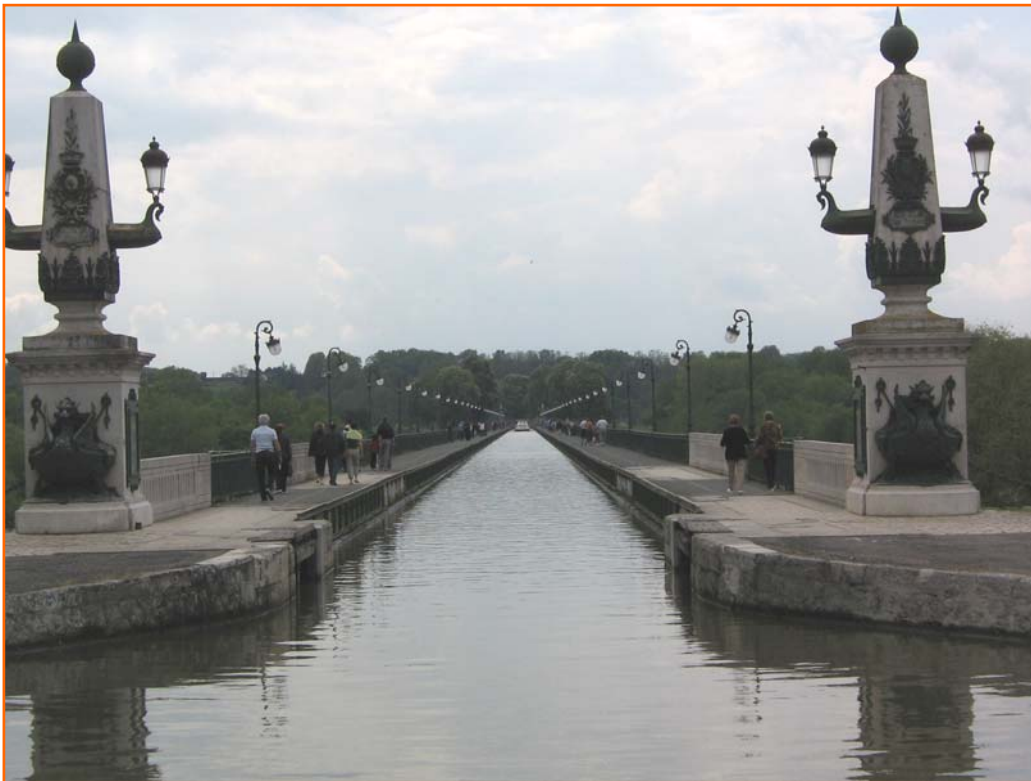
le pont canal de Briare
